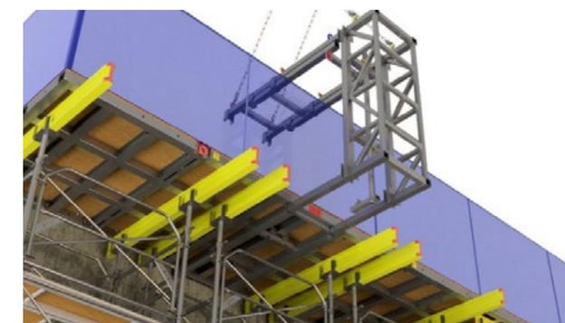
**3 -** Mettre en place le palonnier en glissant les fourches dans les fourreaux sous le plateau (Guidez le palonnier depuis le plateau si nécessaire) : Elingue position « à vide ».
